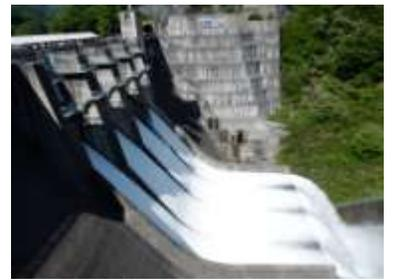
堤高は76.5m、堤頂長127.6m、流域面積は606.9km<sup>2</sup>、洪水調節、発電などが目的とされたダムで、上水道供給の目的はなく、正確には首都圏の水がめとはいえませんが、夏の湯水期には時々テレビなどで首都圏の水がめの一つとして紹介されることがあります。
