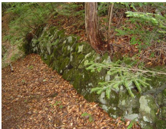
六林班峠からの旧道に残る石垣
