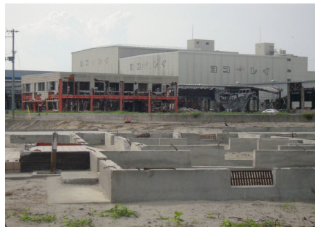
津波で壊された倉庫と土台だけが残る家の跡
