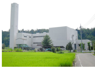
白岩町の清掃工場
