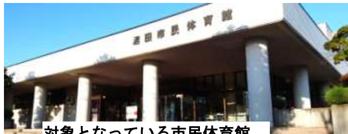
対象となっている市民体育館
