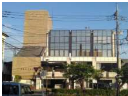
廃止が検討されている中央公民館
