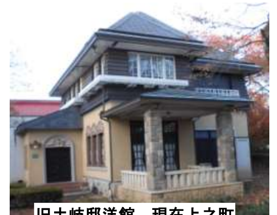
旧土岐邸洋館、現在上之町に移築工事を行っている。
