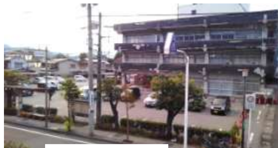
旧市役所跡地
