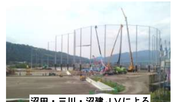
沼田・三川・沼建JVによる野球場・テニスコートの工事が進む(仮称)利南運動広場
