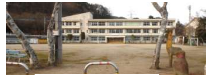
解体工事が始まる元利根西小
