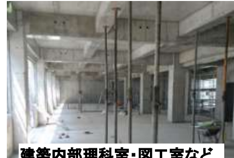
建設中の利根小学校
