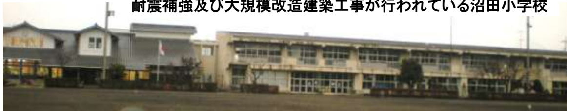
耐震補強及び大規模改造建築工事が行われている沼田小学校
