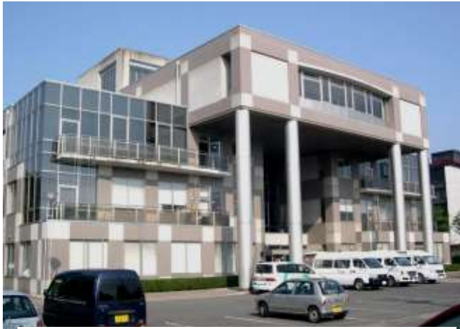
大規模改修が行われている保健福祉センター
