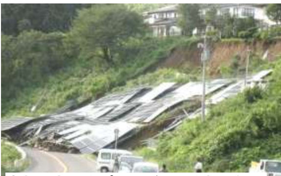
崩れた太陽光パネルが設置された斜面
