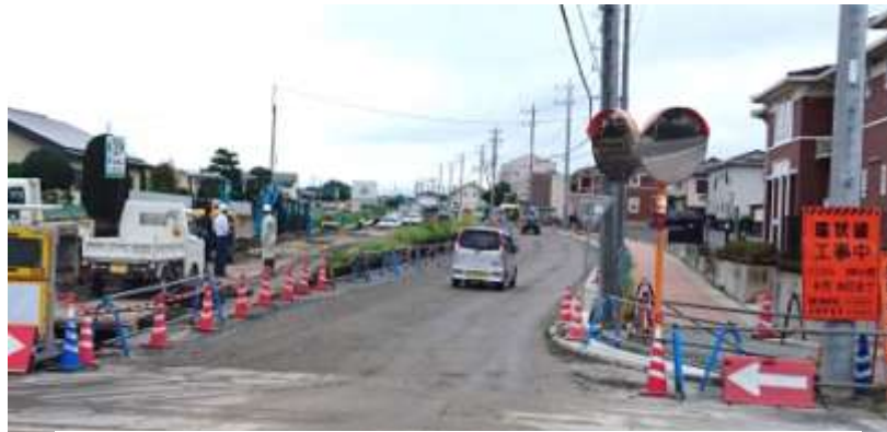
県道大間々線に向かって工事が進む環状線栄町工区
