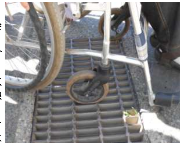
車いすの前輪が網目が広くてはまってしまいう古い型のグレイチングが使われている
