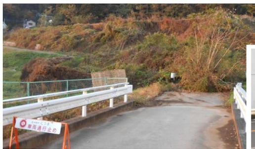
正面の大きな土手が崩落し、土砂が道路を完全にふさいでしまった
