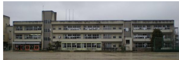
大規模改修が予定されている東校舎
