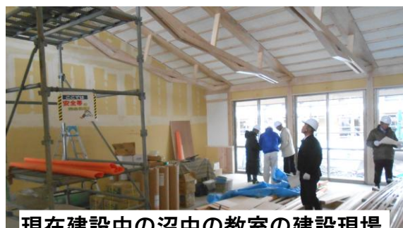
現在建設中の沼中の教室の建設現場
