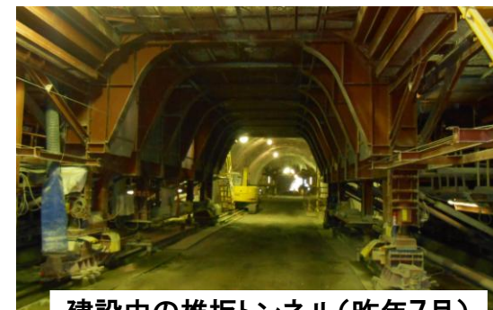
建設中の椎坂トンネル(昨年7月)
