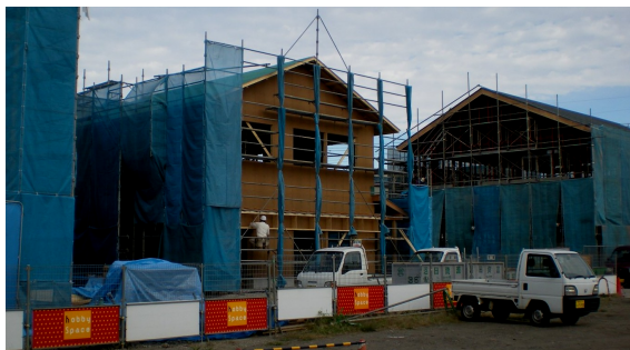
建設中の上之町会館と店舗（右）
