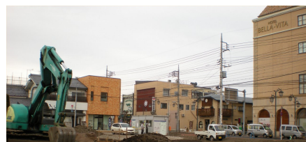
建設工事が始まった上之町1街区 右はホテルベラヴィータ
