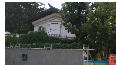
解体移築される生方文庫
