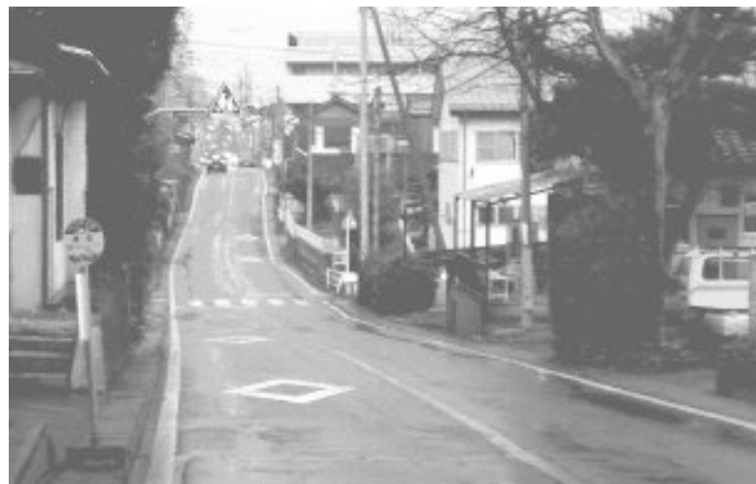
死亡事故も起きている歩道もなく狭い柳町市道
