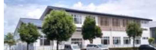
保健福祉センター側からの外観
