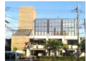
ついに解体されて しまう文化の殿 堂中央公民館
