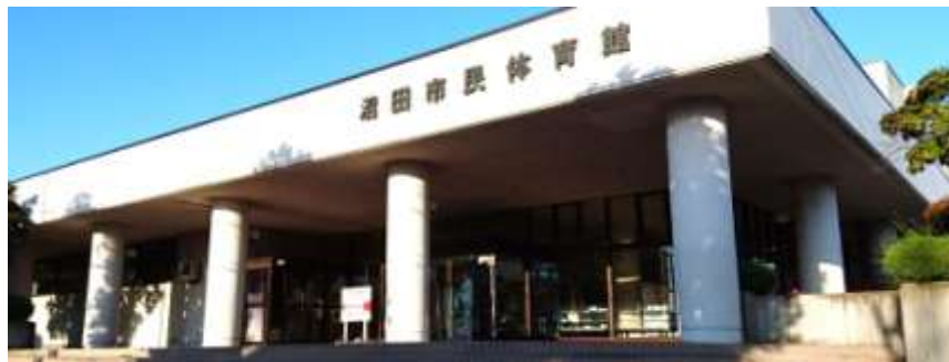
改修工事が行われる沼田市民体育館
